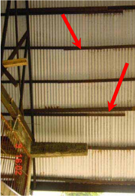
Geknoei met kapconstructies Knoeiwerk met nokplaten en scheve dakranden. Zie ook scheuren in de betonnen bakgoot
