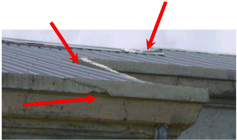
Geknoei met kapconstructies Knoeiwerk met nokplaten en scheve dakranden. Zie ook scheuren in de betonnen bakgoot
