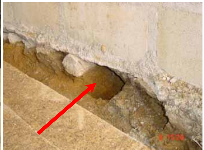
Scheurende en omvallende muren. Na gravingen blijkt er GEEN fundering te zijn geplaatst
