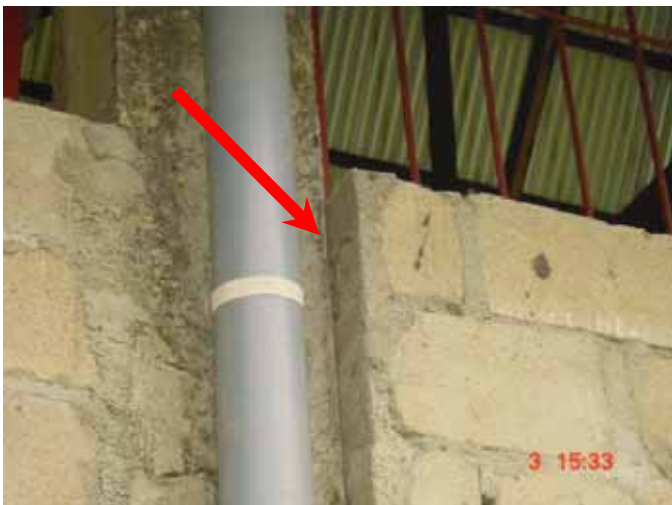
Scheurende en omvallende muren. Na gravingen blijkt er GEEN fundering te zijn geplaatst
